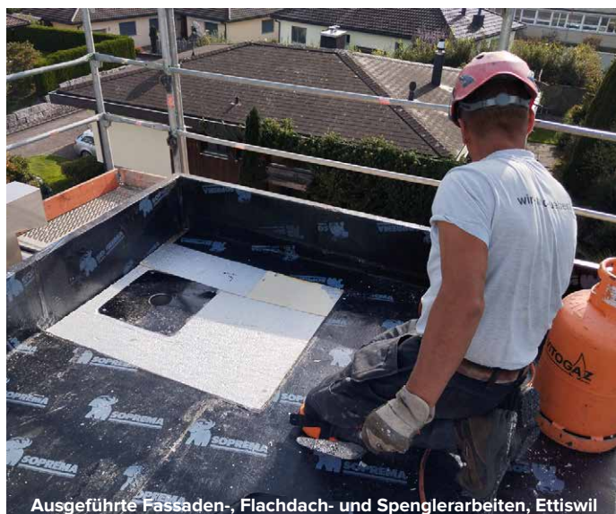
Ausgeführte Fassaden-, Flachdach- und Spenglerarbeiten, Ettiswil
